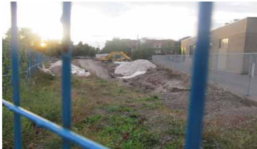
Photo 2. Chantier (09-2013)-Installation Rhéaume
